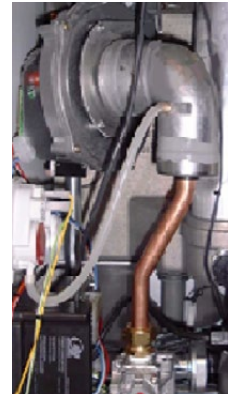
Drukmeter aansluiten. Gemeten waarde bij startbelasting min -180 millibar of hoger
