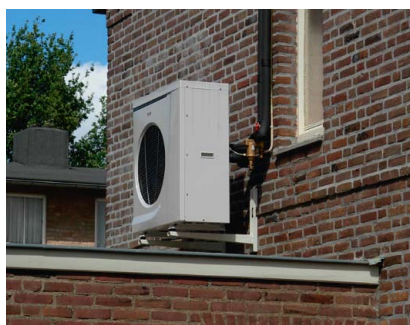
4 Hoog hangend zijkant woning
