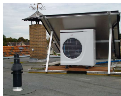
6 Plat dak woning met zonnecollector
